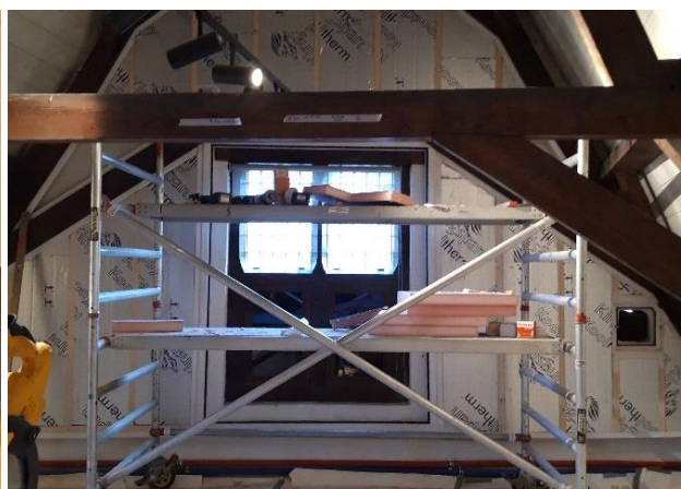
De aannemer aan het werk met de voorzetwand
