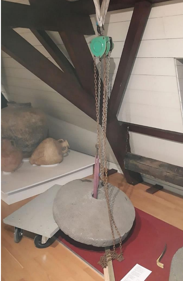
Het liften van de molenstenen en de herplaatsing op de nieuwe sokkels
